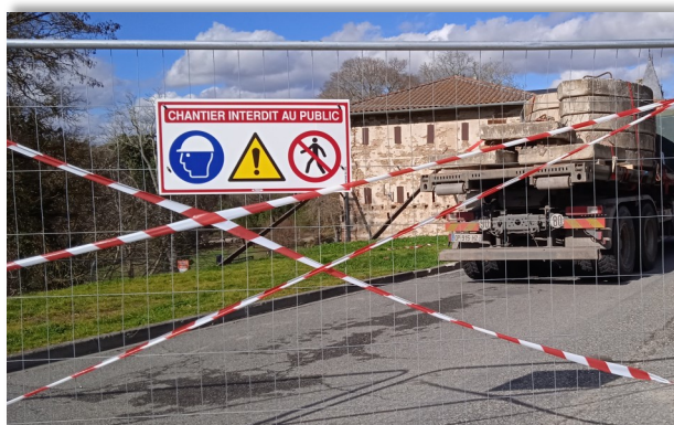
Une vue du chantier
