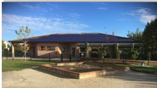
Une vue de l'installation
